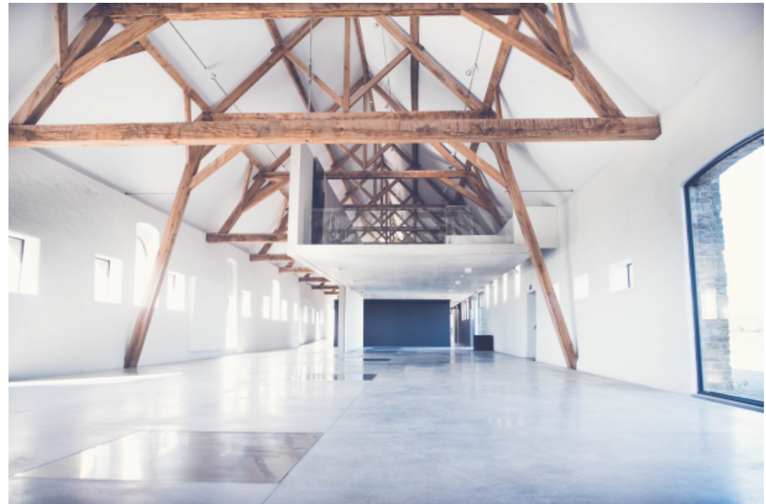
Vue intérieure du centre d'art après la rénovation des architectes Govaert et Vanhoutte. Au-dessus, la grange dans un état de délabrement à une époque antérieure.
